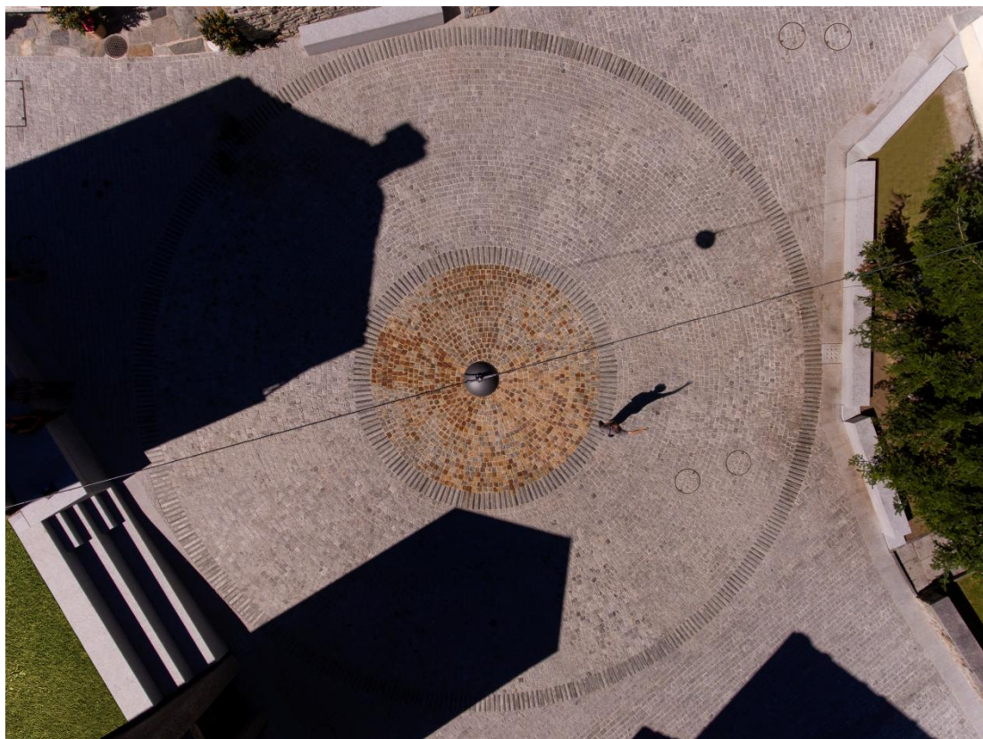
Figura 10. Vista aérea de la plaza de Sonogno. Fotografía: Alberto Canepa.
