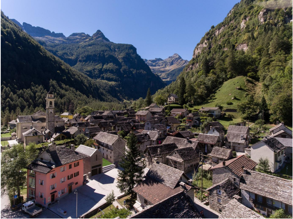
Figura 11. Vista aérea de la plaza de Sonogno. Fotografía: Alberto Canepa.
