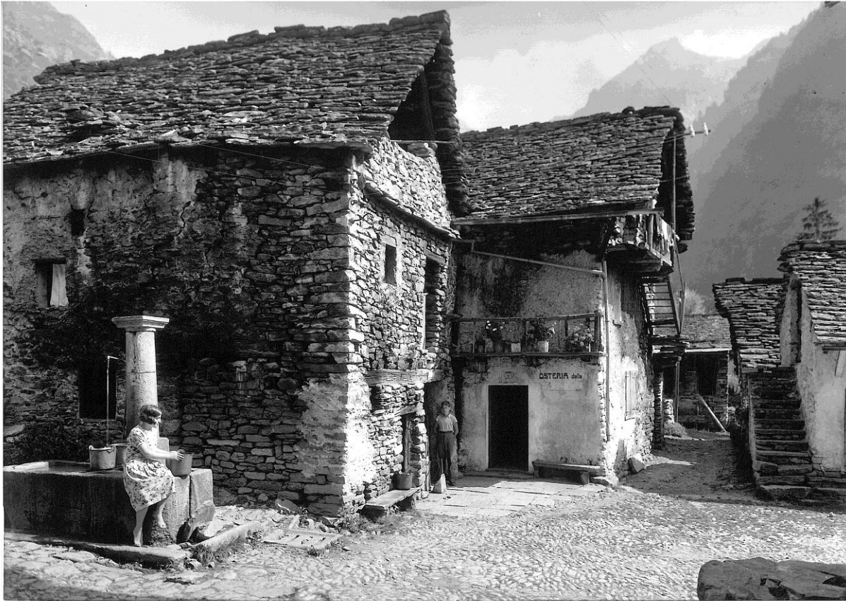
Figura 1. La imagen muestra el edificio de la "osteria", ahora una tienda de artesanía. El edificio entre la fuente y la tienda fue demolido, mientras que la fuente se ha trasladado a otra localización. Se pueden ver dos edificios, actualmente demolidos, a la derecha. En la parte baja, a la derecha, se encuentra la piedra que hoy constituye el pedestal del edificio del museo. (Fotografía histórica, principios del siglo XX)
