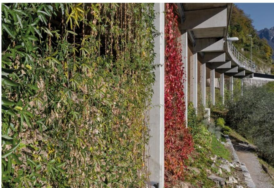
travi HEB 200 sulla mezzaria delle quali sono saldati a distanza regolare di 20 centimetri dei bulloni M27 (diametro bullone 46 mm) che servono per fissare il cavo verticale per i rampicanti. Ogni campata conta con due travi HEB, 64 bulloni, 32 cavi verticali per un totale di
