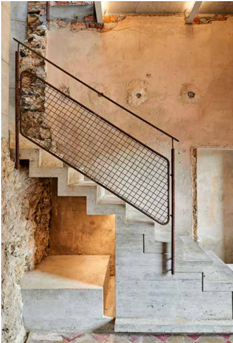
Sopra: pavimento in pietra della terrazza. Sotto: la scala di calcestruzzo armato con parapetto di ferro crudo ossidato. Pagina a fronte: feritoia che illumina la scala ■ Above: the stone floor of the terrace. Below: the reinforced concrete staircase with its oxidised raw iron parapet. Opposite page: a loophole illuminates the staircase
