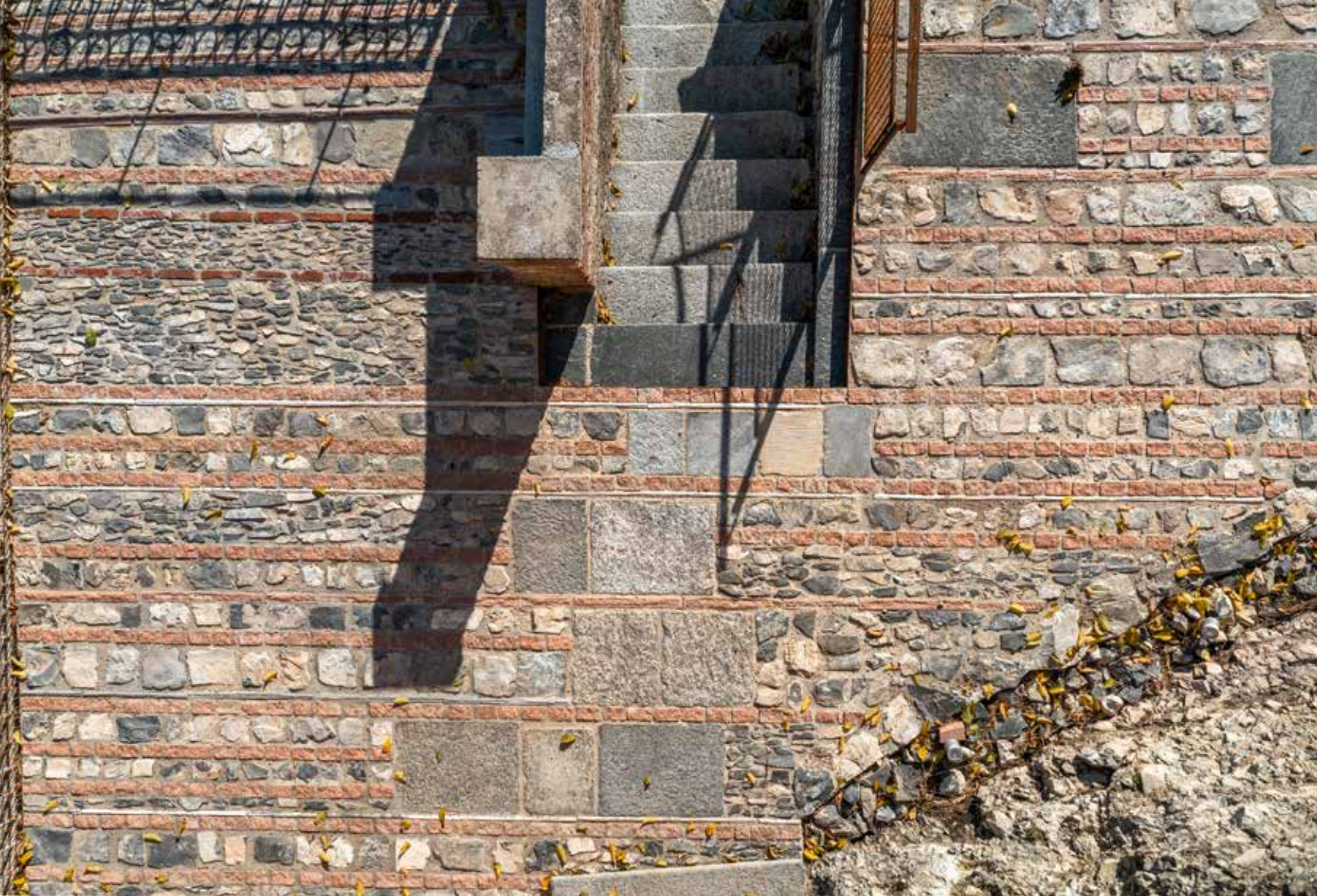
Sopra: pavimento in pietra della terrazza. Sotto: la scala di calcestruzzo armato con parapetto di ferro crudo ossidato. Pagina a fronte: feritoia che illumina la scala ■ Above: the stone floor of the terrace. Below: the reinforced concrete staircase with its oxidised raw iron parapet. Opposite page: a loophole illuminates the staircase
